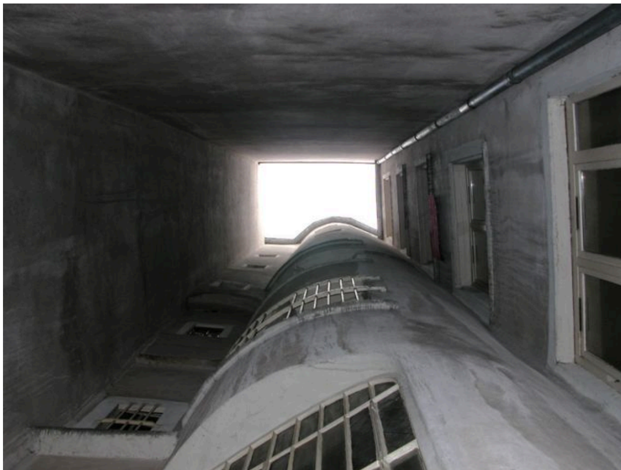
Cour, vue générale par-dessous
