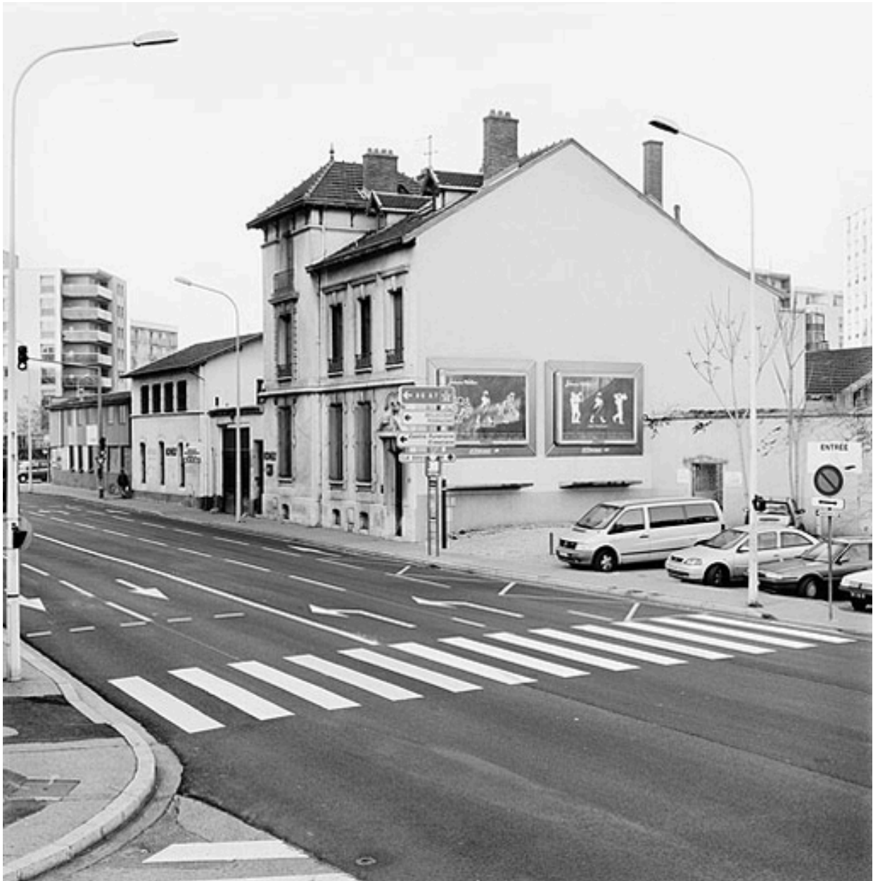
Vue générale sud-est, maison patronale
