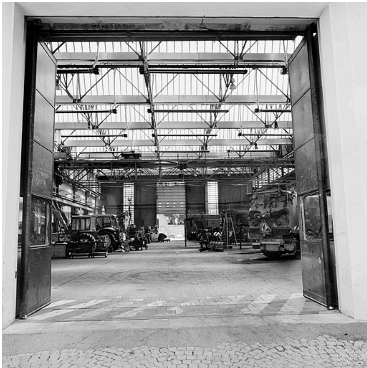
Vue intérieure du hall mécanique
