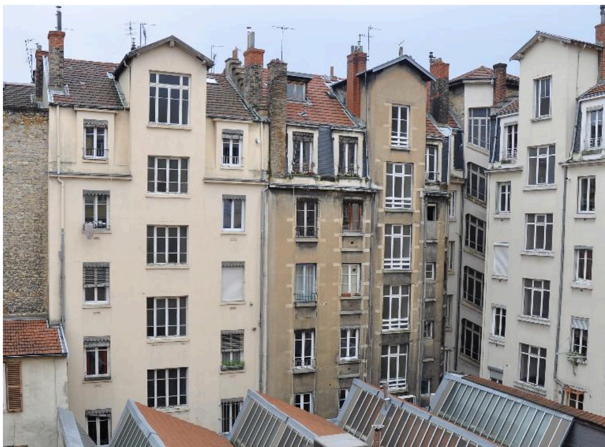
Vue d'ensemble de l'élévation sur cour
