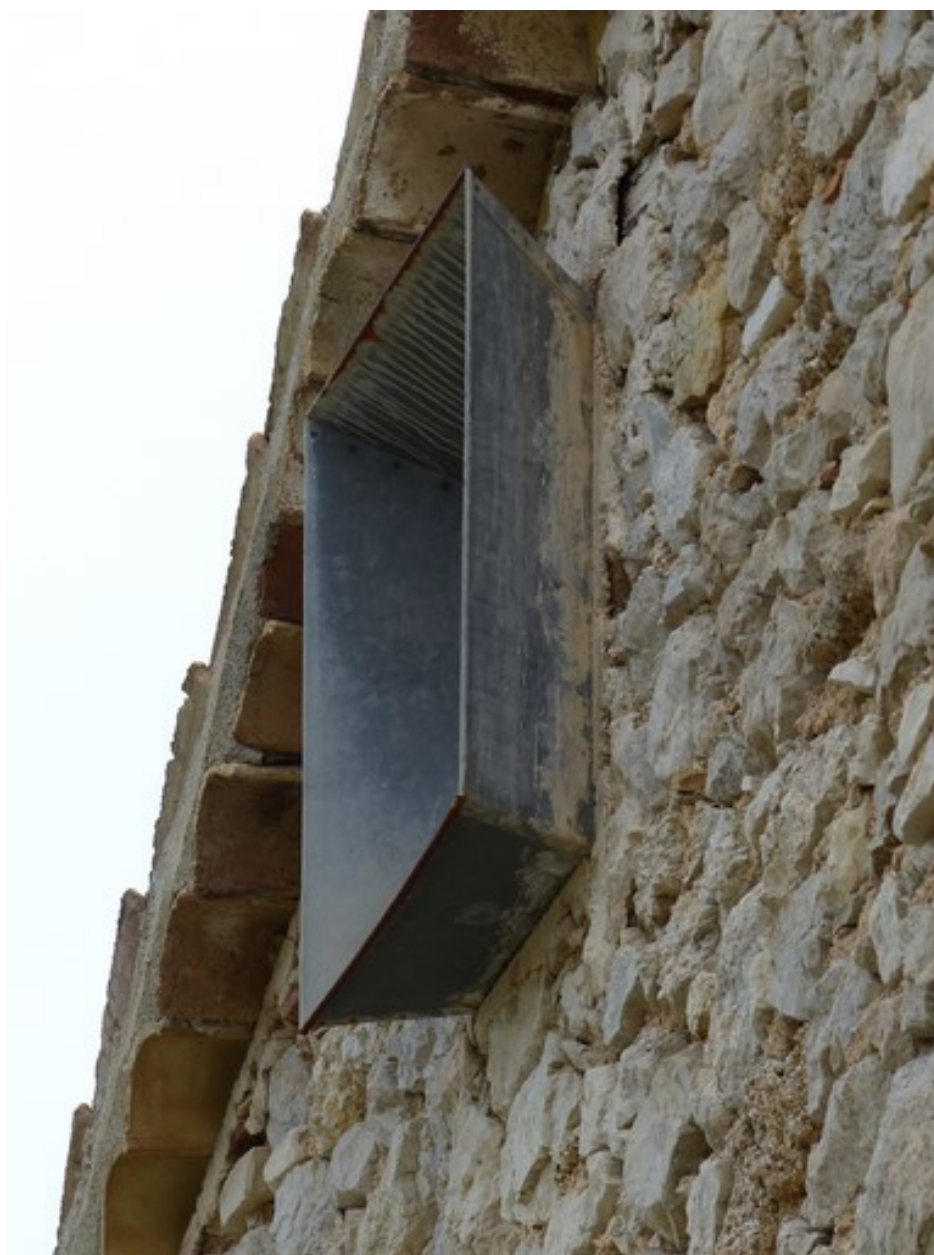
Pignon sud, troisième niveau. Baie du pigeonnier, protection ébrasée en zinc.
