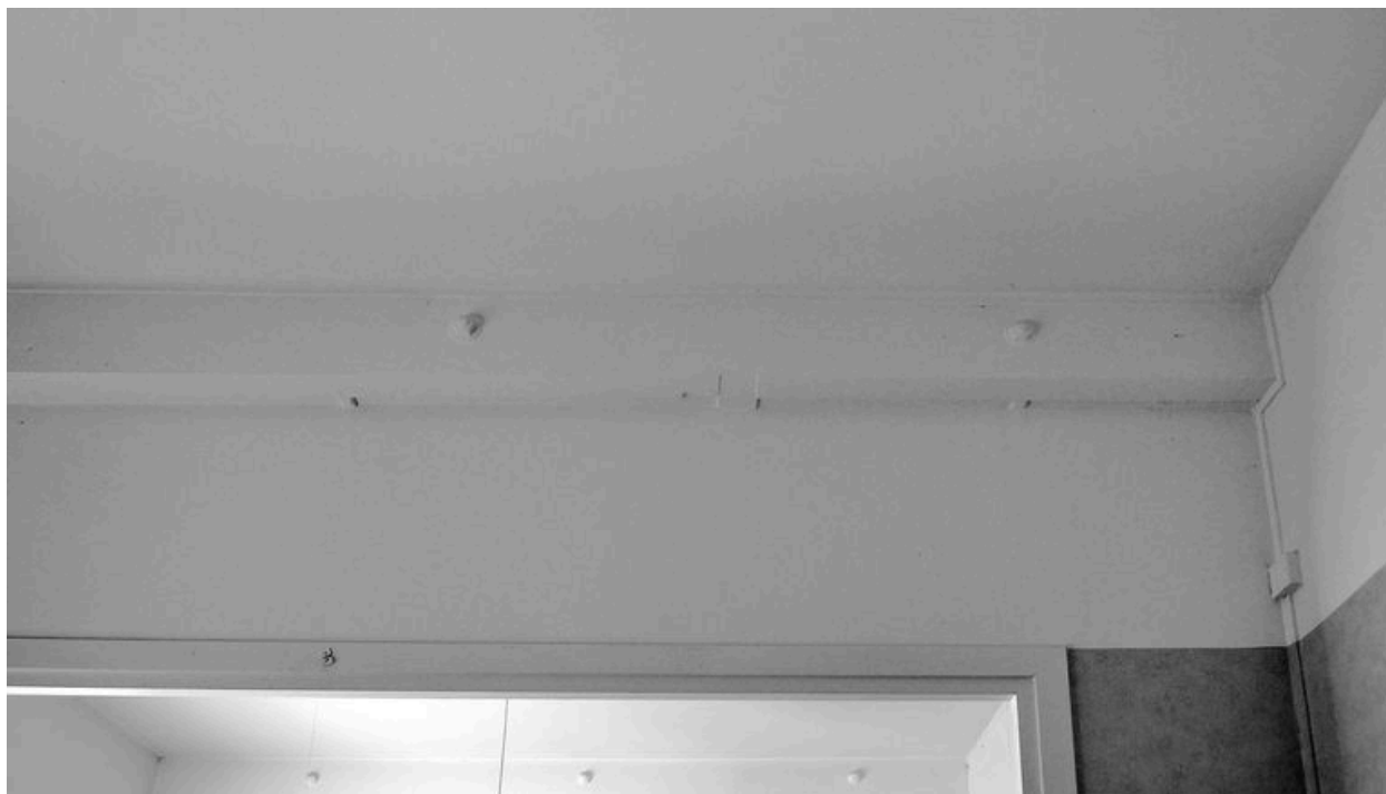
3e étage : détail d'une poutre boulonnée.
