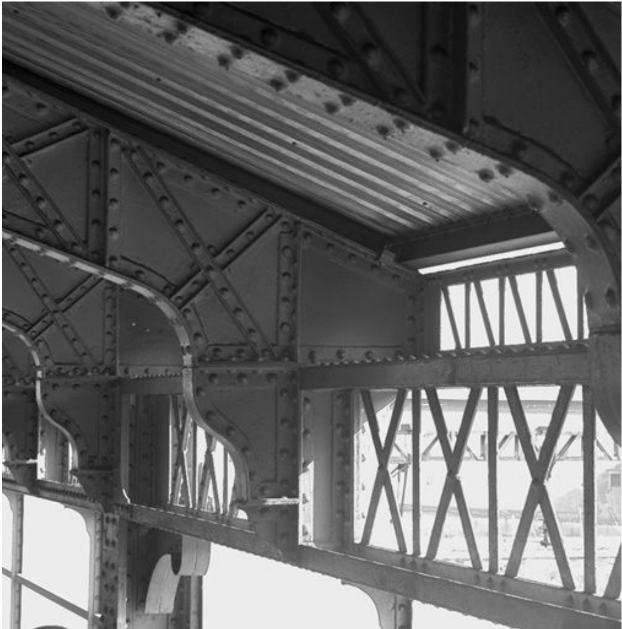
Halles : détail de la charpente métallique
