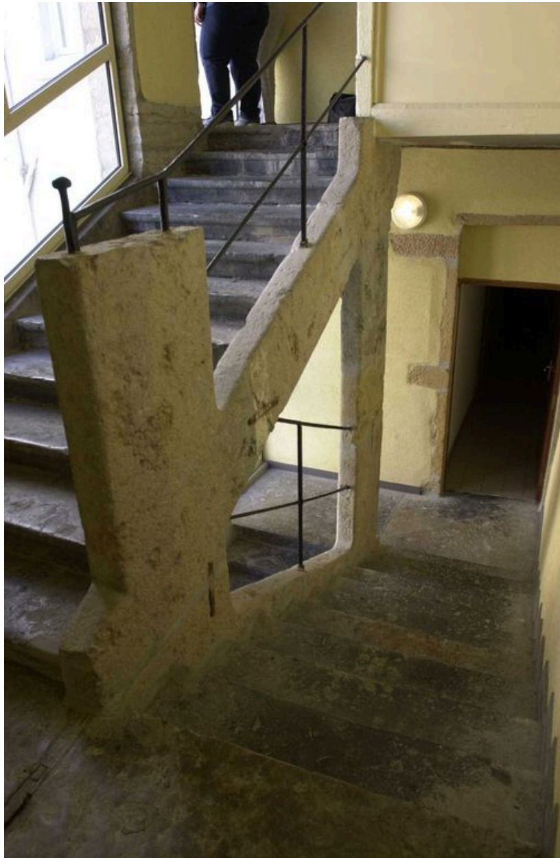
Vue de l'escalier avec mur-noyau ajouré
