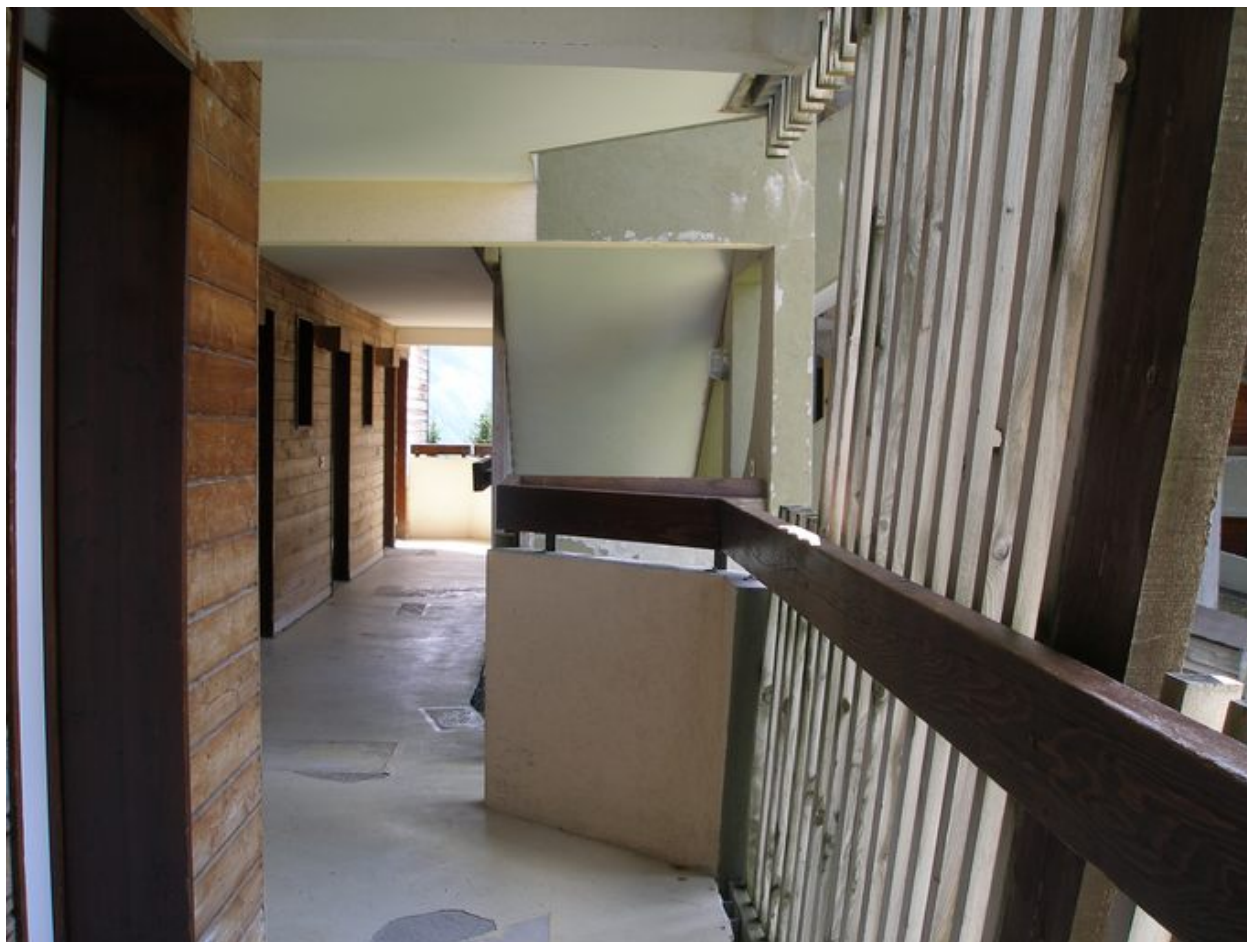
Vue d'une coursière
