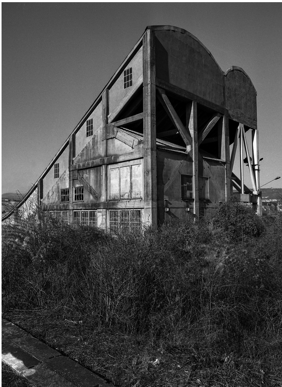
Pistes d'essais en 2005, avant destruction.
