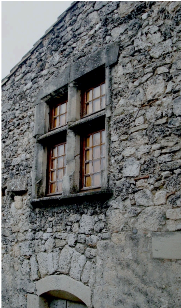
Corps postérieur, élévation sur cour, détail : fenêtre à croisée.
