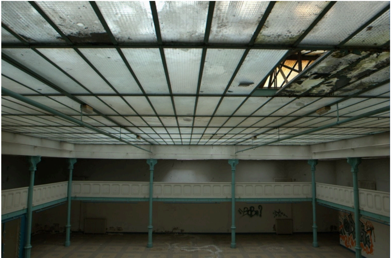
Vue nord de la halle
