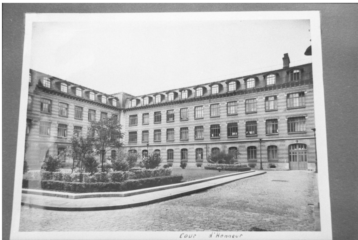
Cour d'honneur; cour carrée nord, photographie s.d (archives, Manufacture des tabacs de Lyon)
