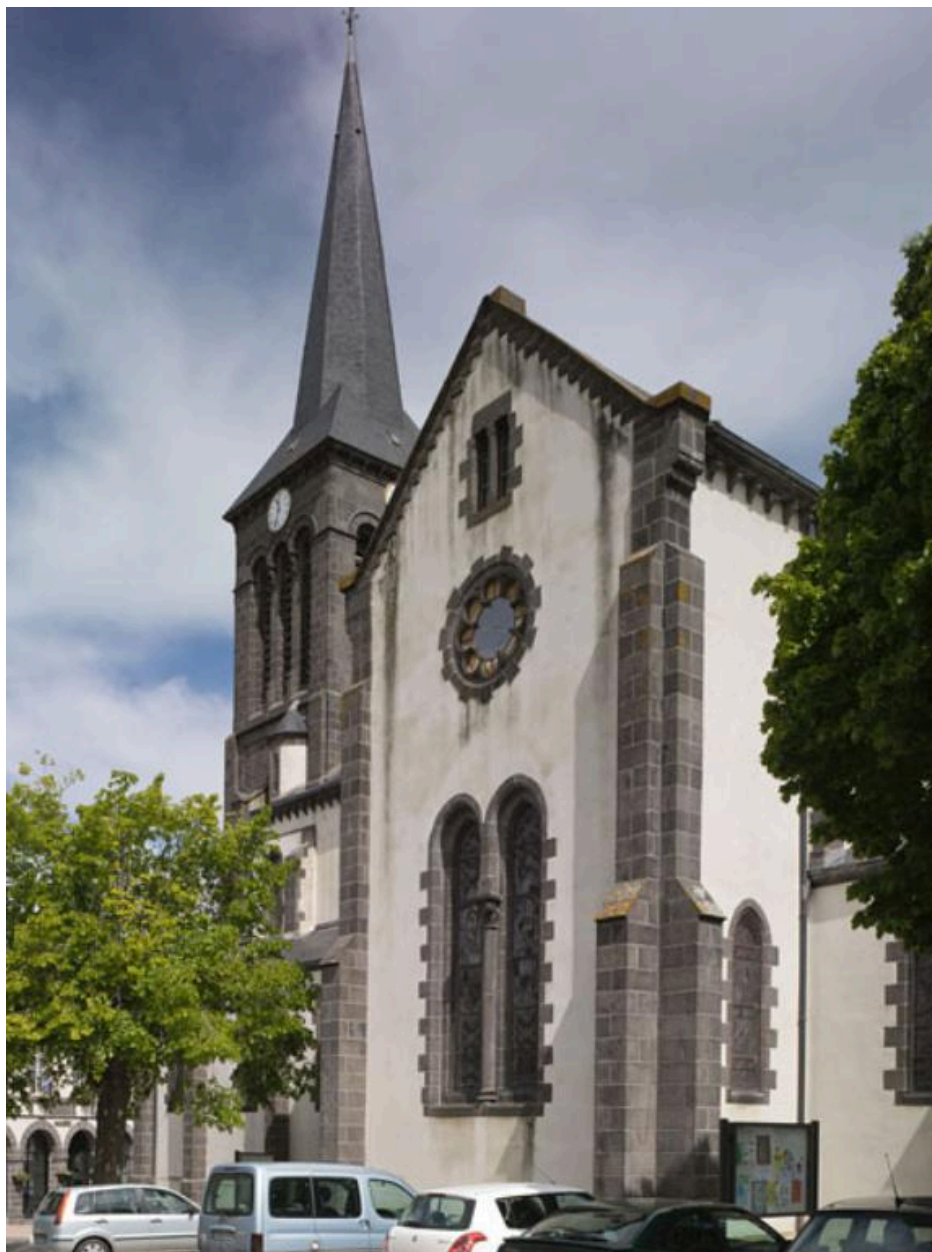
Vue générale transept sud.
