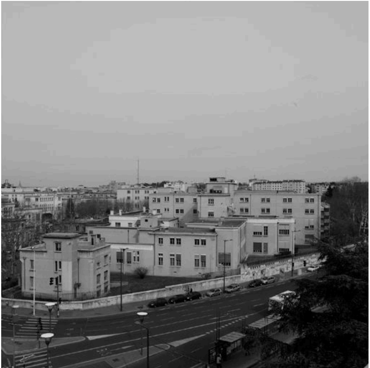
Vue d'ensemble depuis le sud-ouest : les pavillons 17, J-K et L
