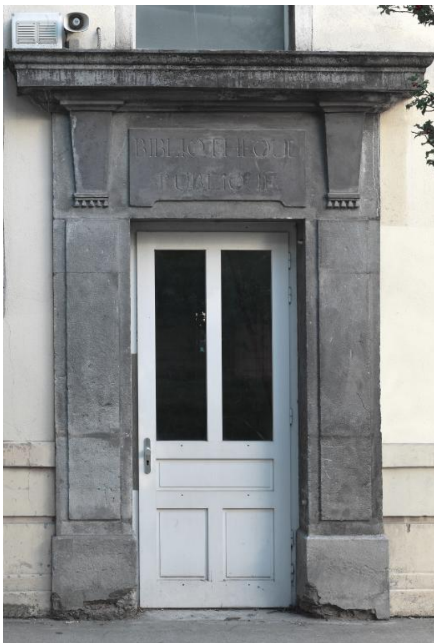
Corps de bâtiment ouest : ancienne porte d'entrée de la bibliothèque publique, côté cour
