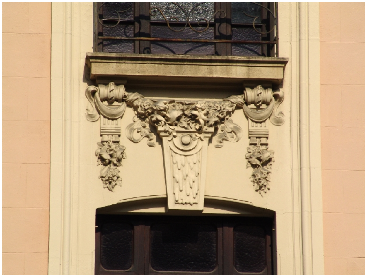
Détail du décor de la façade est
