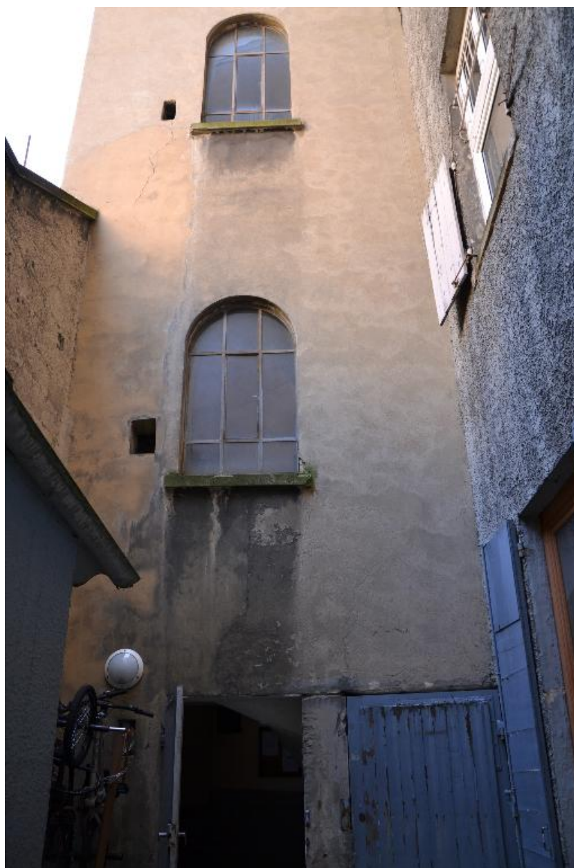
Façade ouest sur cour
