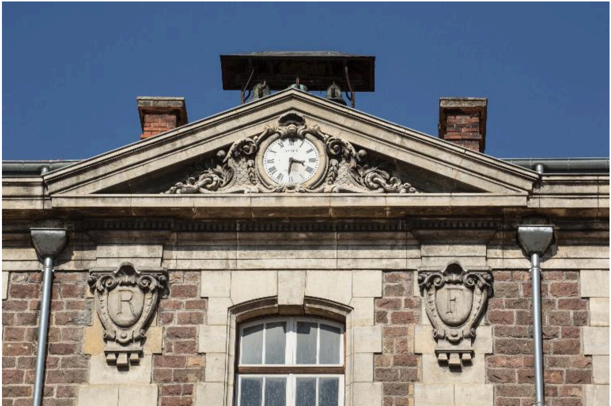
Bâtiment A. Travée centrale, détail : fronton et ornementation
