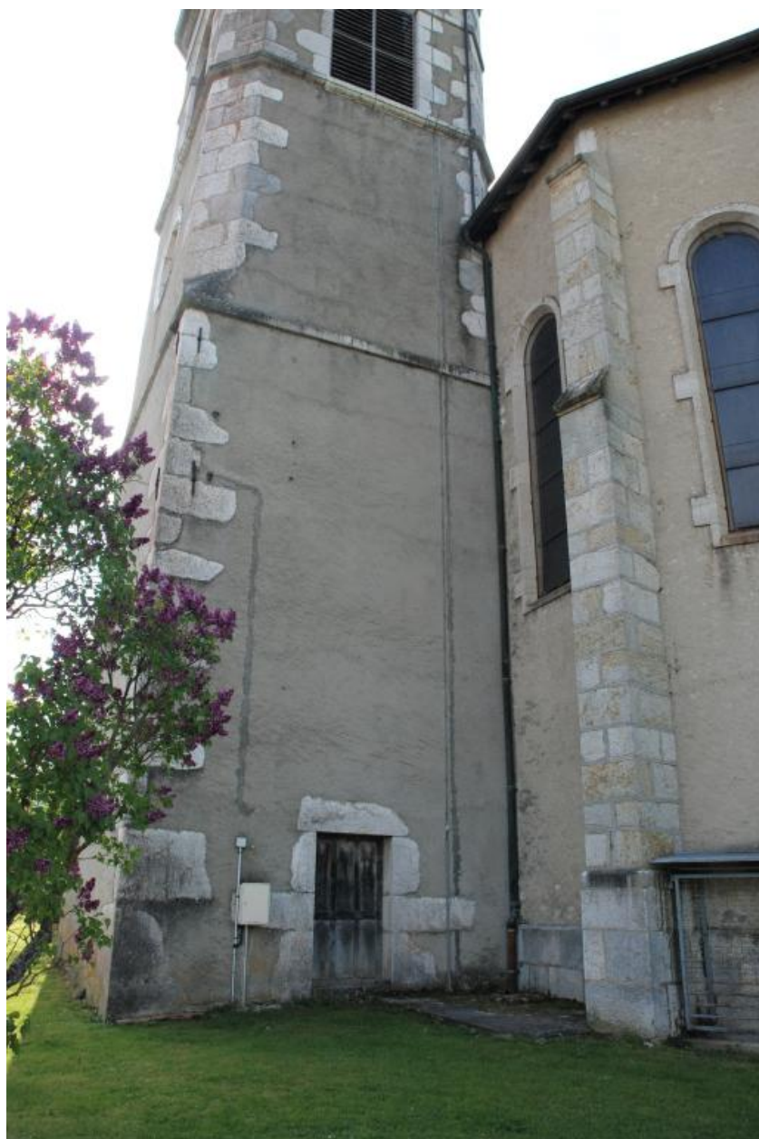
Base du clocher, face ouest.
