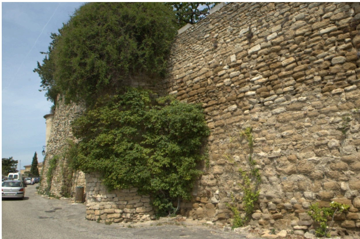
Rue Sous-les-remparts, vestiges de l'enceinte du bourg côté sud-ouest, vue prise depuis le sud : courtine et tours.
