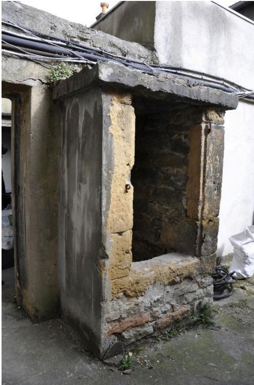
Vue du puits dans la cour
