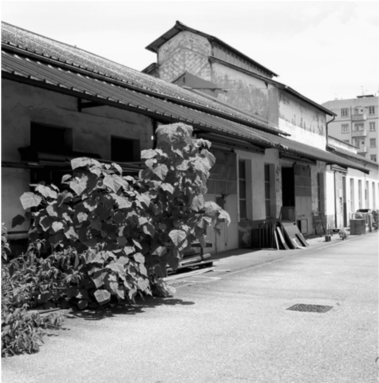
Détail circulation ouest
