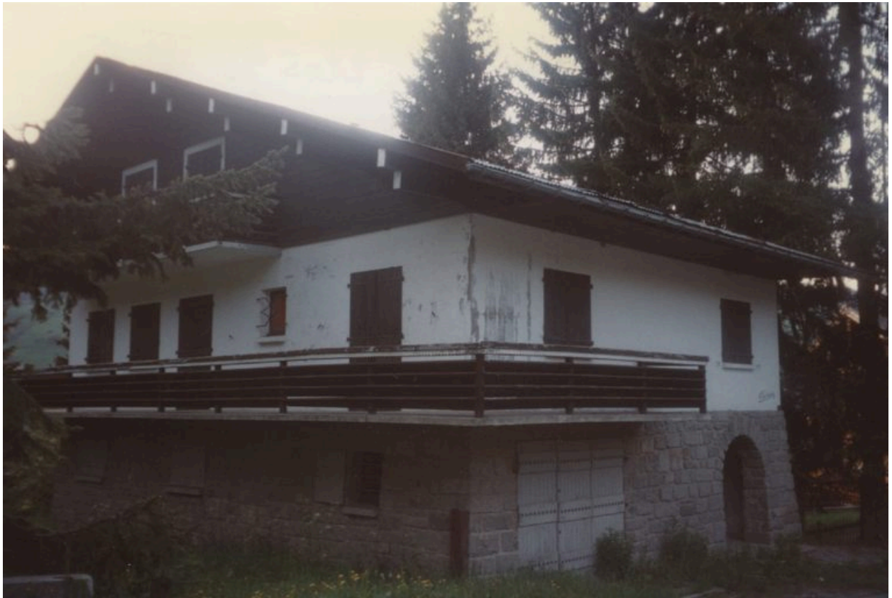
Vue d'ensemble depuis le sud-est. Etat en 1995
