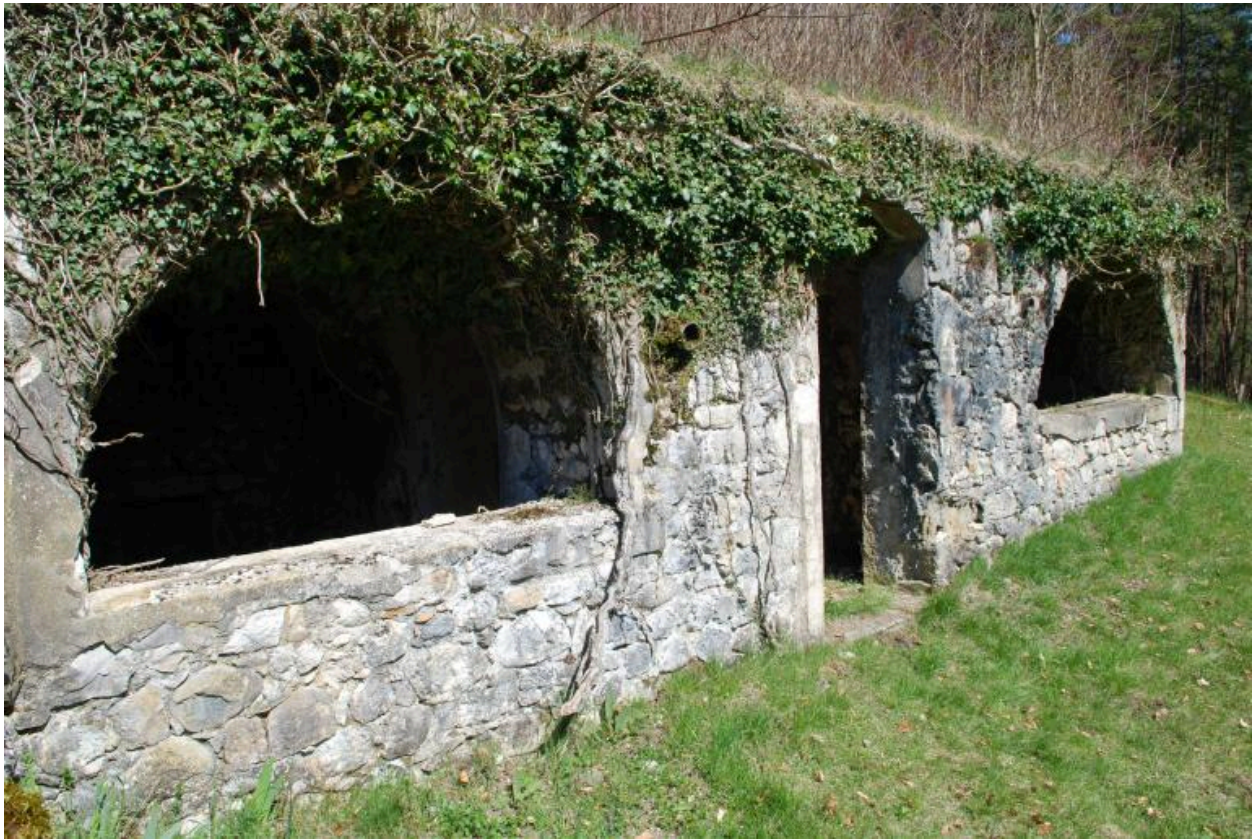
Vue d'ensemble de l'abri situé au pied du château.
