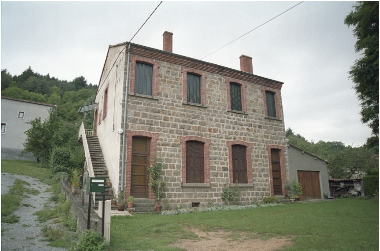
Goutard, maison à double logis (1986 C2 1035). Bâtiment en moellons, avec encadrements, corniche et chaînage d'angle en brique. Vue d'ensemble de trois-quarts avant gauche.
