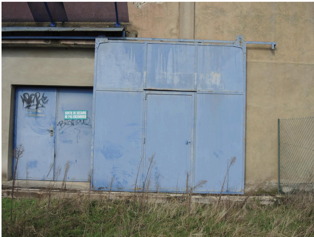
Hangar VI photo vue d'une façade d'extérieure (portes)
