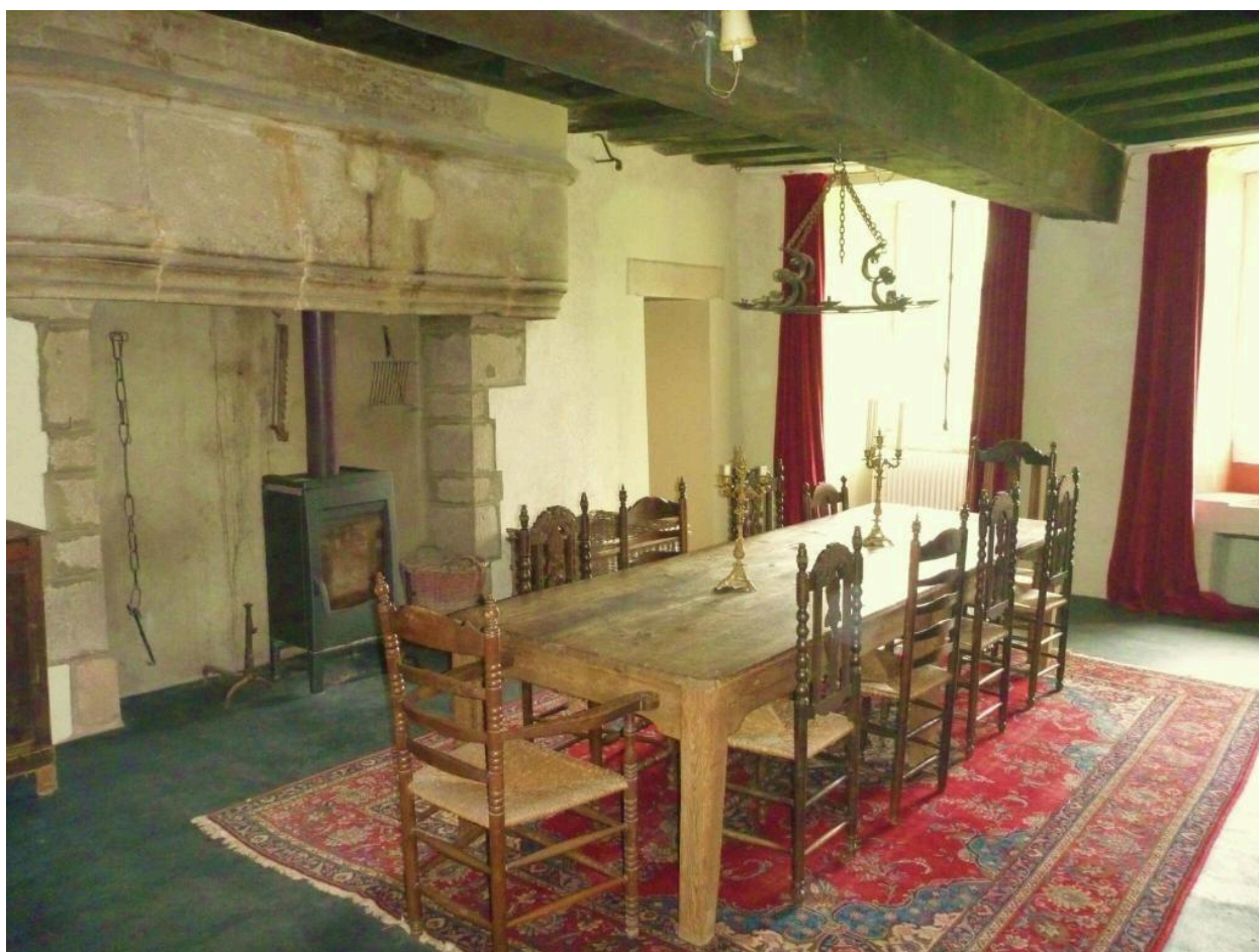
Vue générale de la cheminée n°3.
