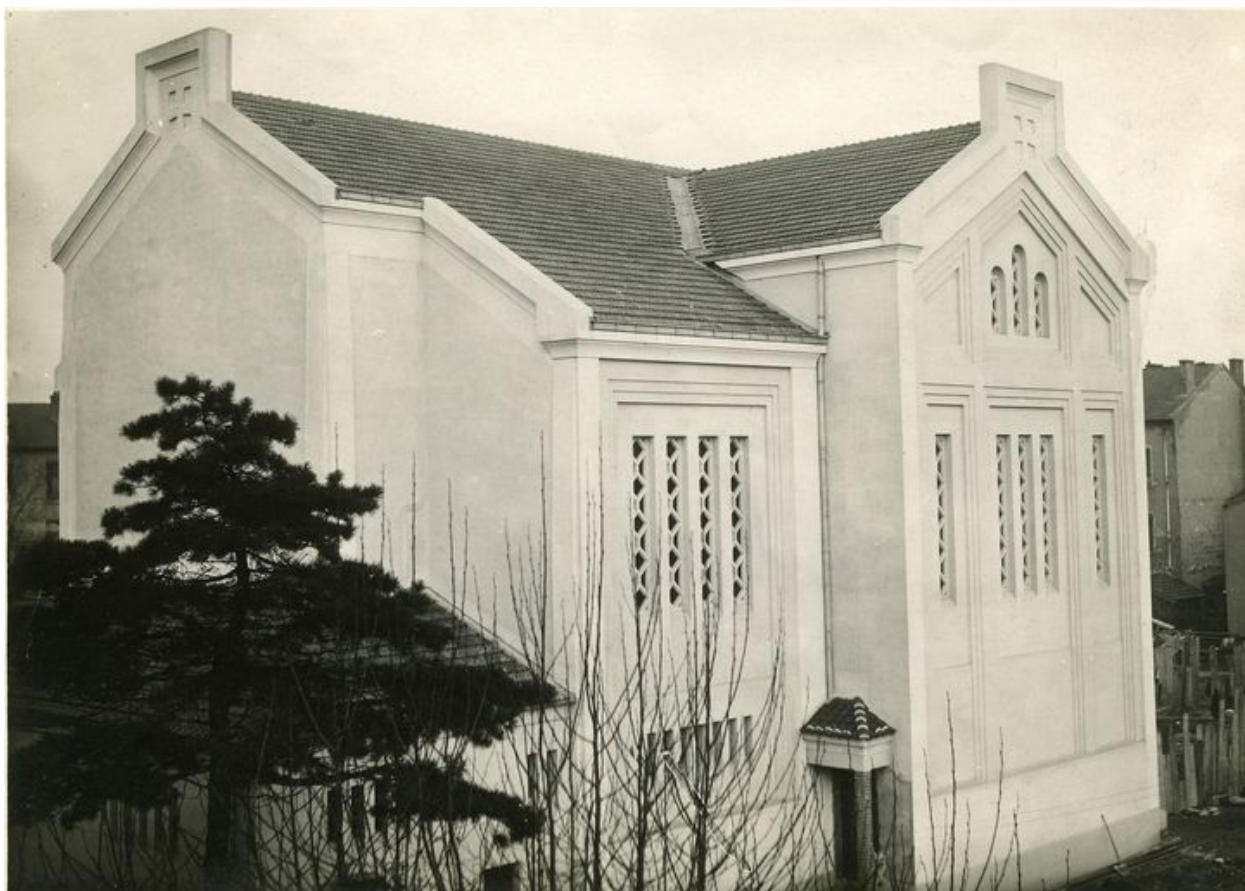
Le chœur achevé. Photogr., fin 1927 (AP Saint-Vincent-de-Paul)
