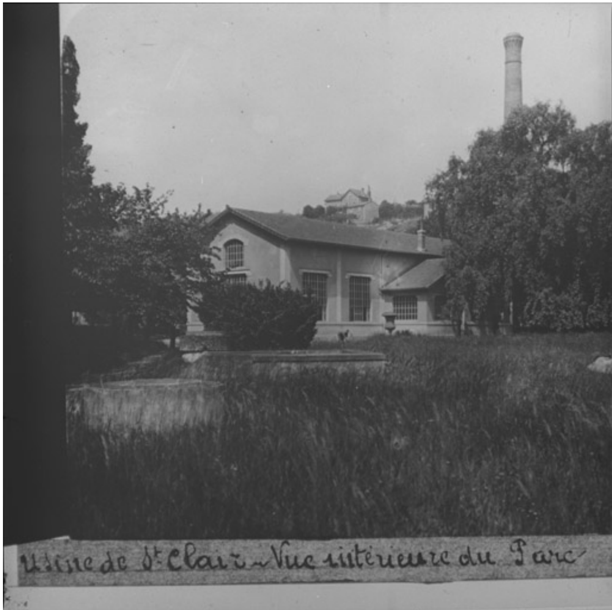
Usine de St-Clair : vue intérieure du parc (Cie générale des eaux)
