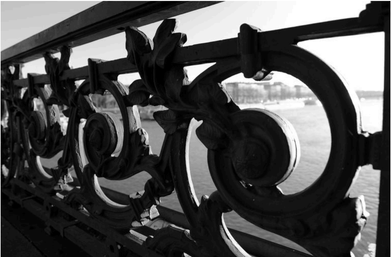
Balustrade, face amont, vue partielle : de côté (depuis la chaussée)
