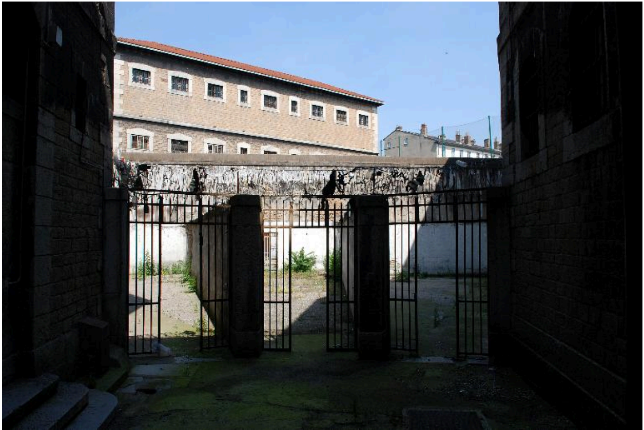
Etat en 2010 : les cours de promenade nord-est
