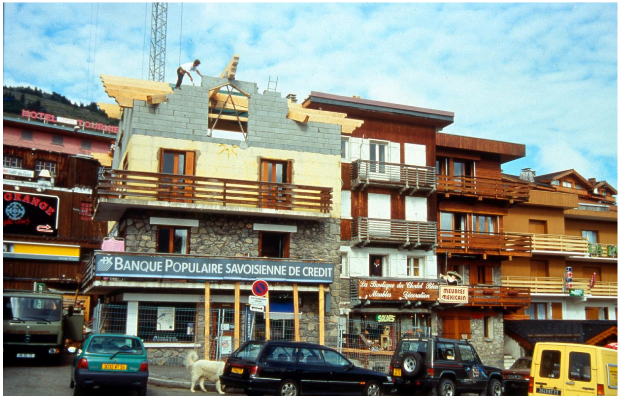
Elévation sud pendant les travaux. Phase 2
