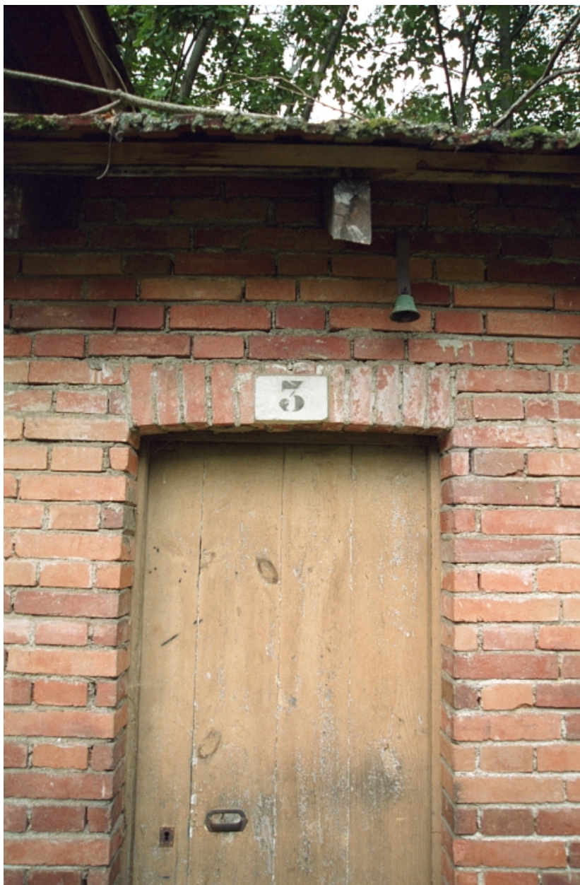
Bains douche installés sur le site de la carderie, détail d'une entrée.
