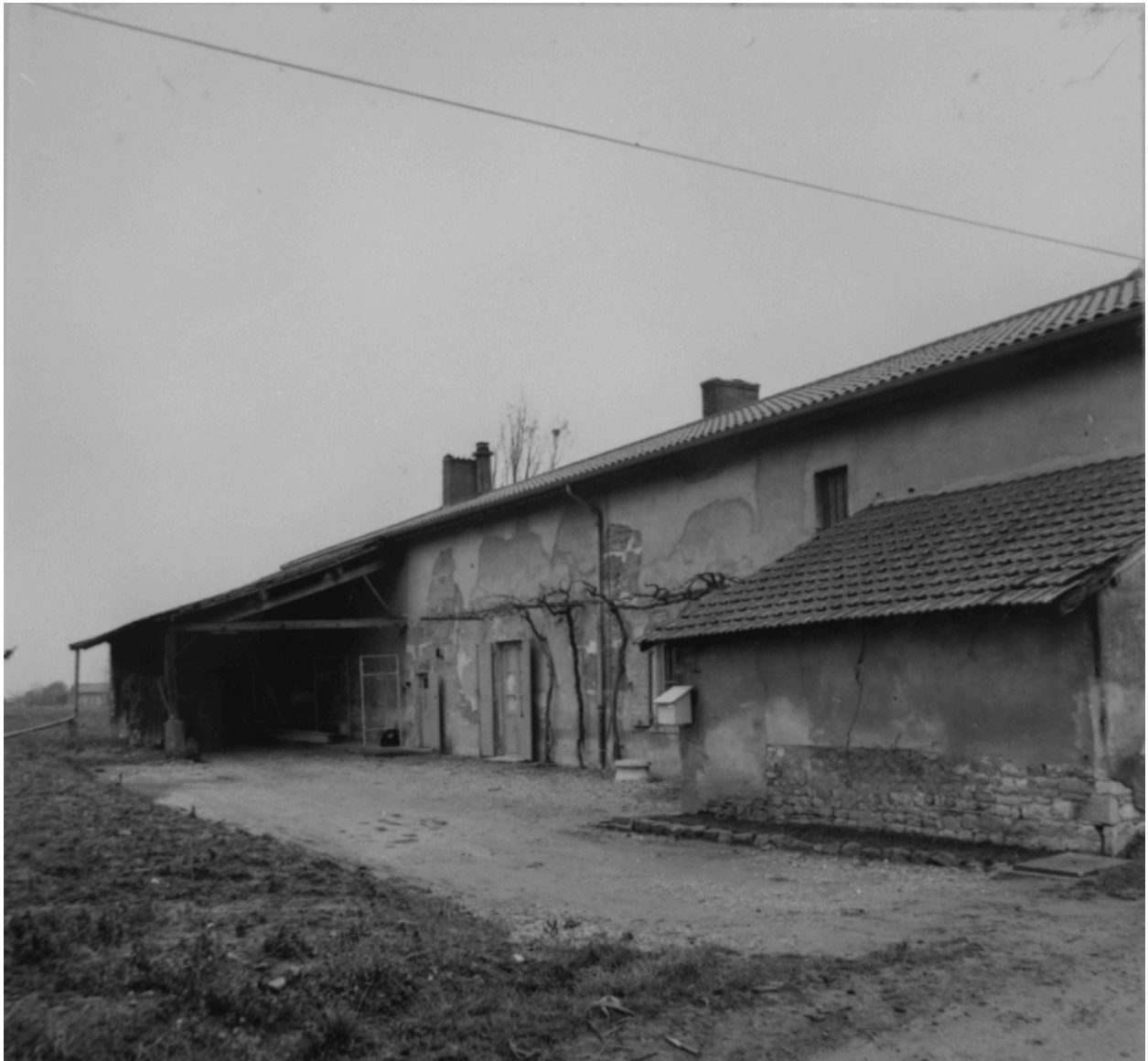
Vue d'ensemble de l'élévation postérieure.
