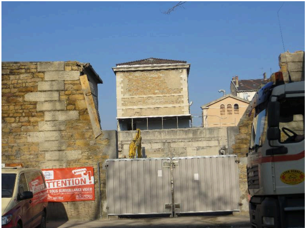
Etat au 19 février 2013 : au centre, le mur-pignon du bâtiment arrière (rue Delandine) depuis le cours Suchet
