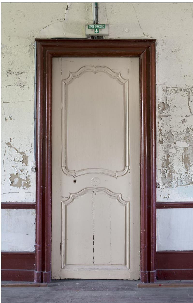
Premier étage, une des portes ouvrant dans le vestibule
