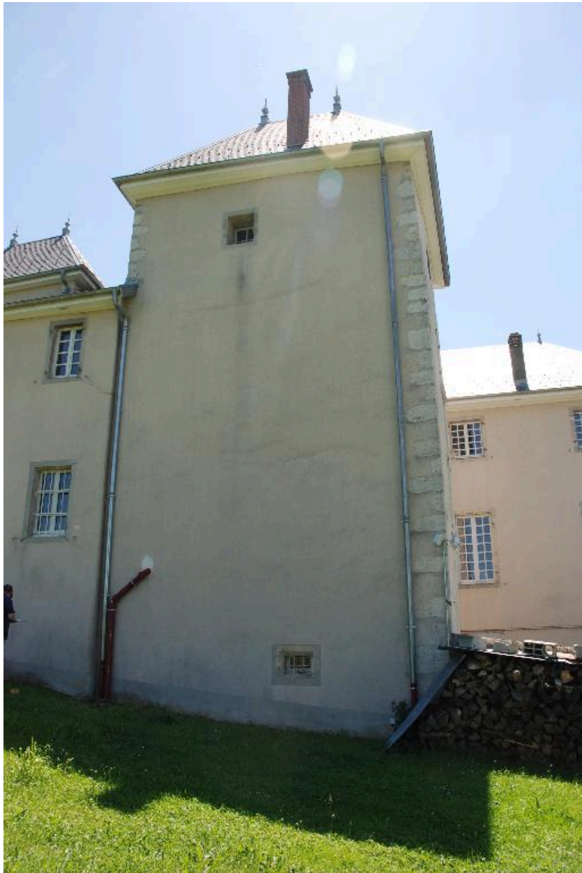
Vue partielle de la façade nord du château.
