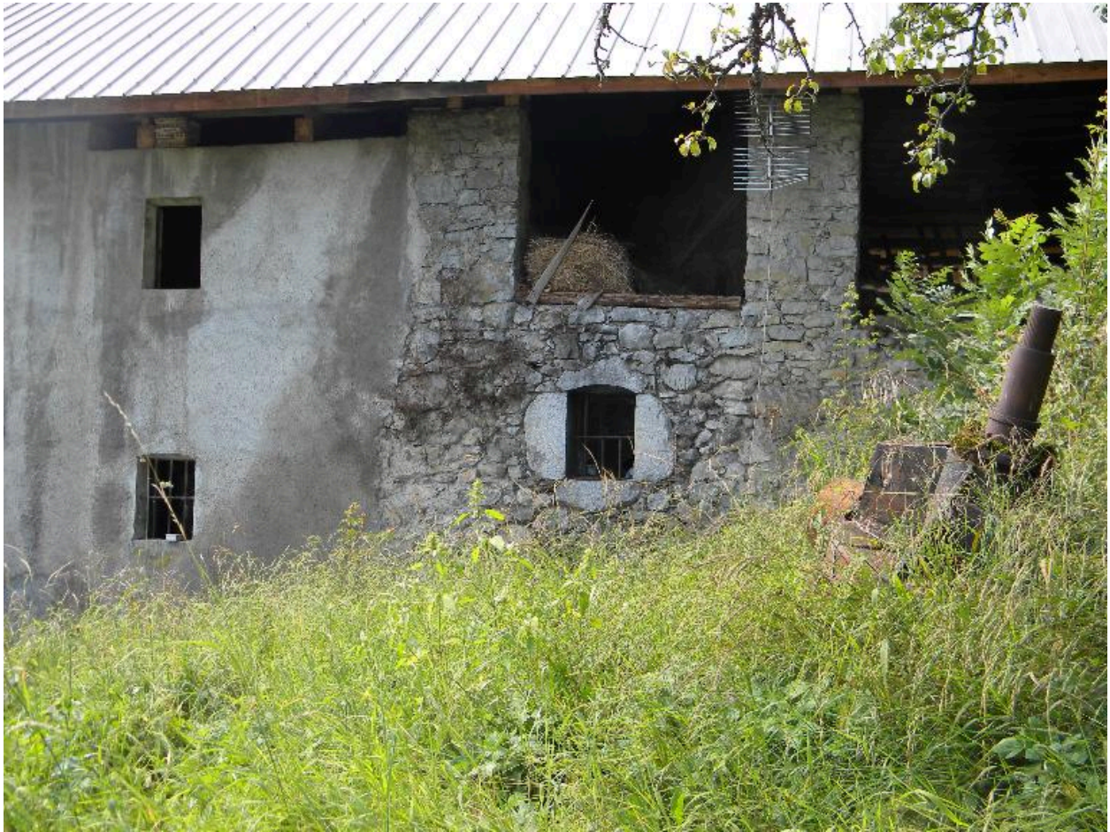
Façade arrière avec une fenêtre au linteau délardé.
