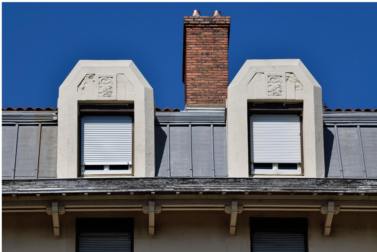
Détail de deux lucarnes
