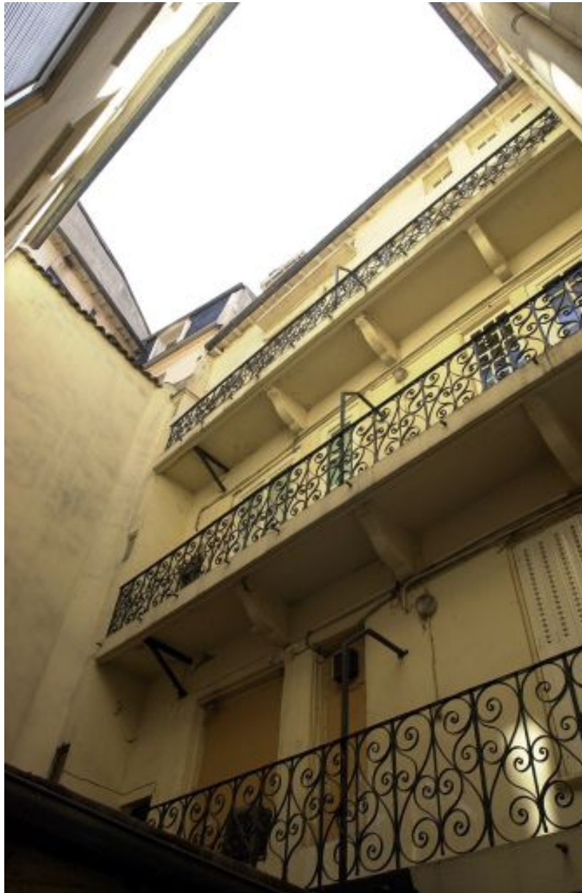
1er corps de logis, façade sur cour, partie gauche
