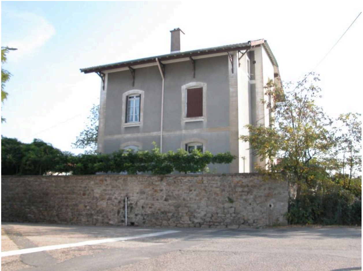
Purelles (les), maison 1986 AL 275. Maison des années 1940, vue d'ensemble de revers;
