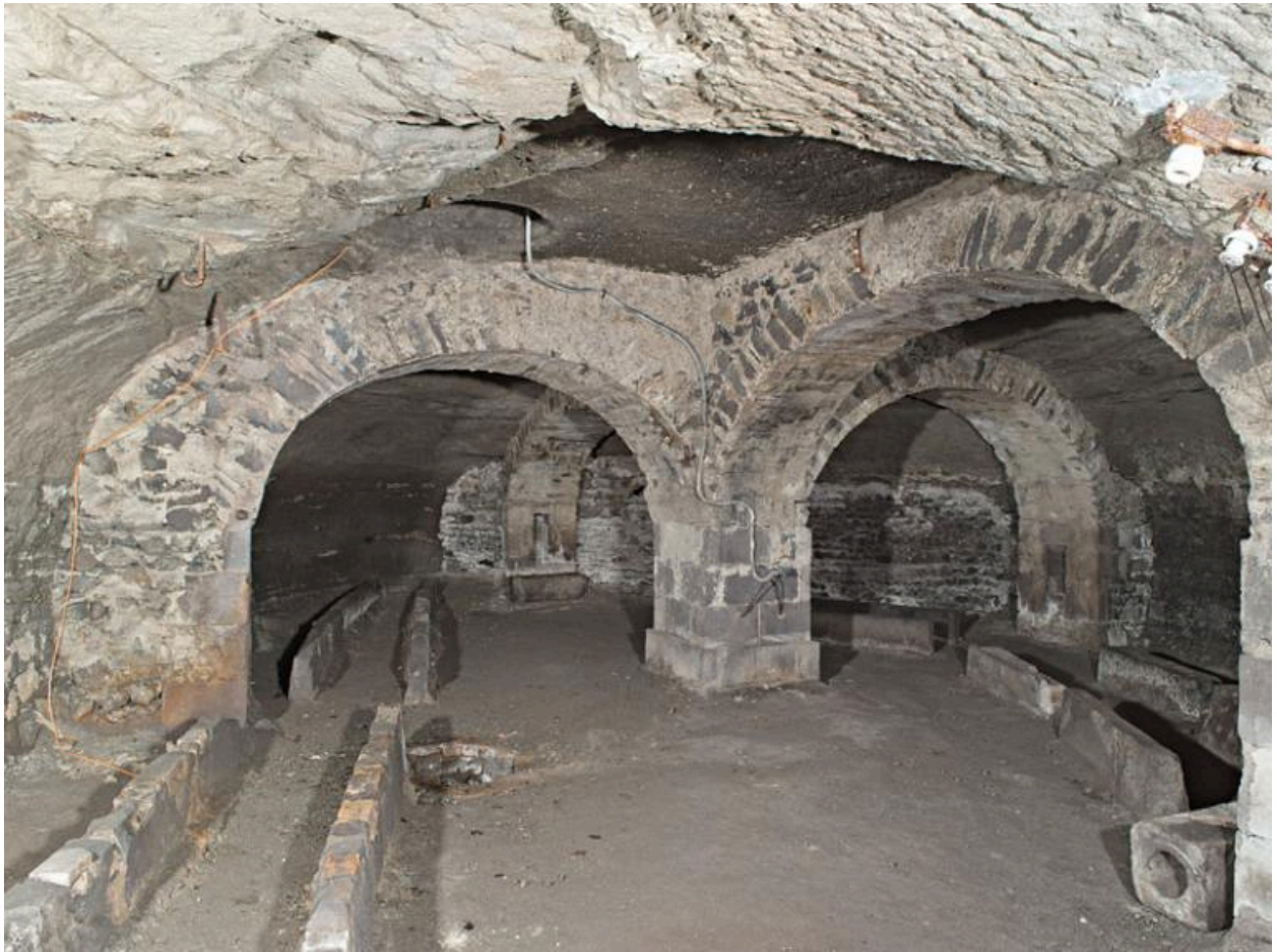
Hôtel-Dieu de Clermont-Ferrand. L'hôtel-Dieu, les galeries souterraines, salle dite "du Bonnet carré" vue du sud-ouest.
