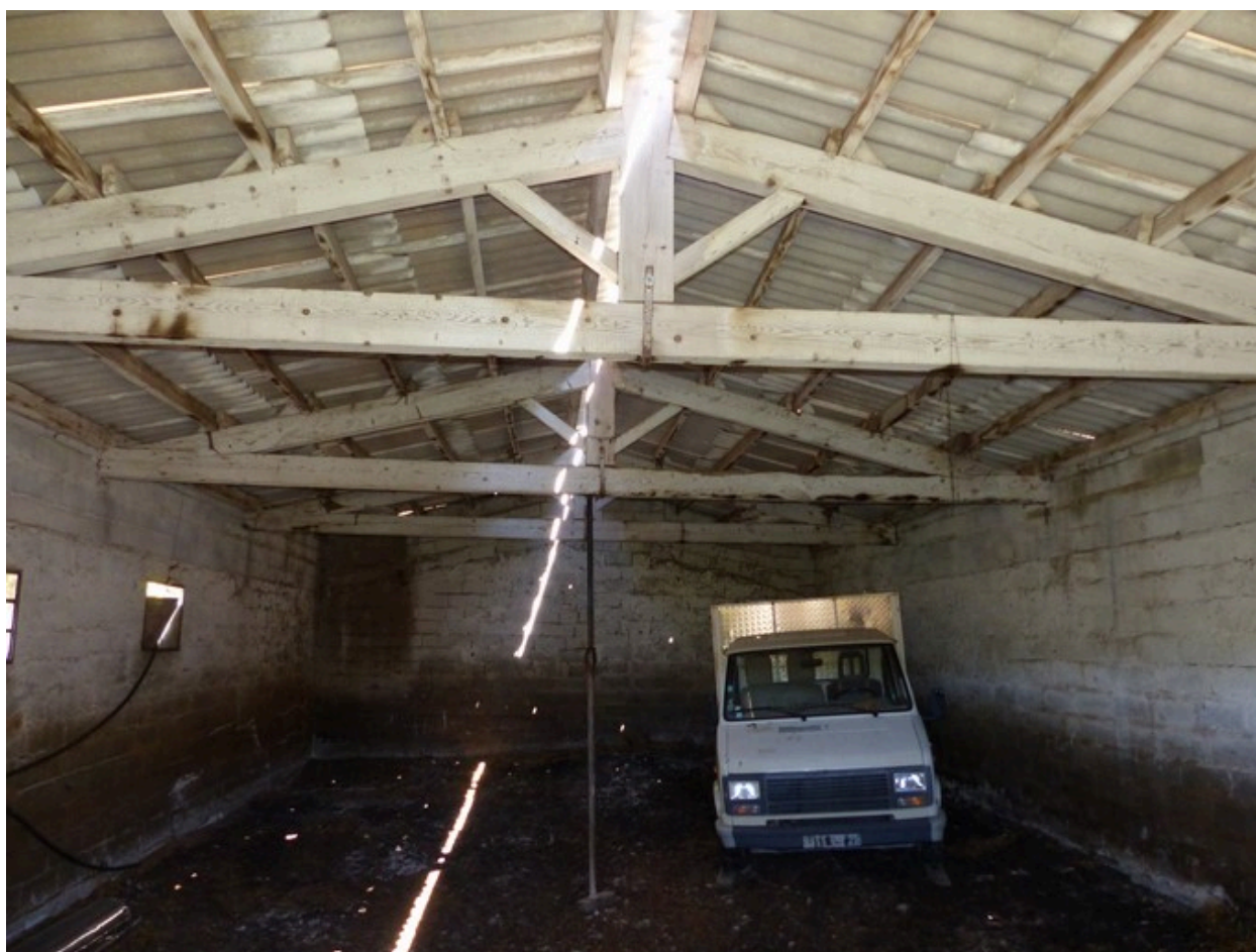
Charpente à fermes, bergerie au quartier de Font-Nouvelle.
