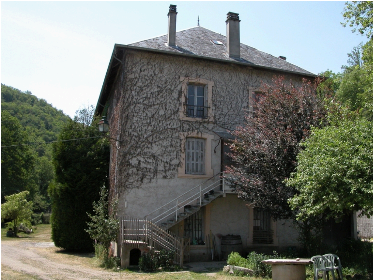
Vue du mur pignon ouest.
