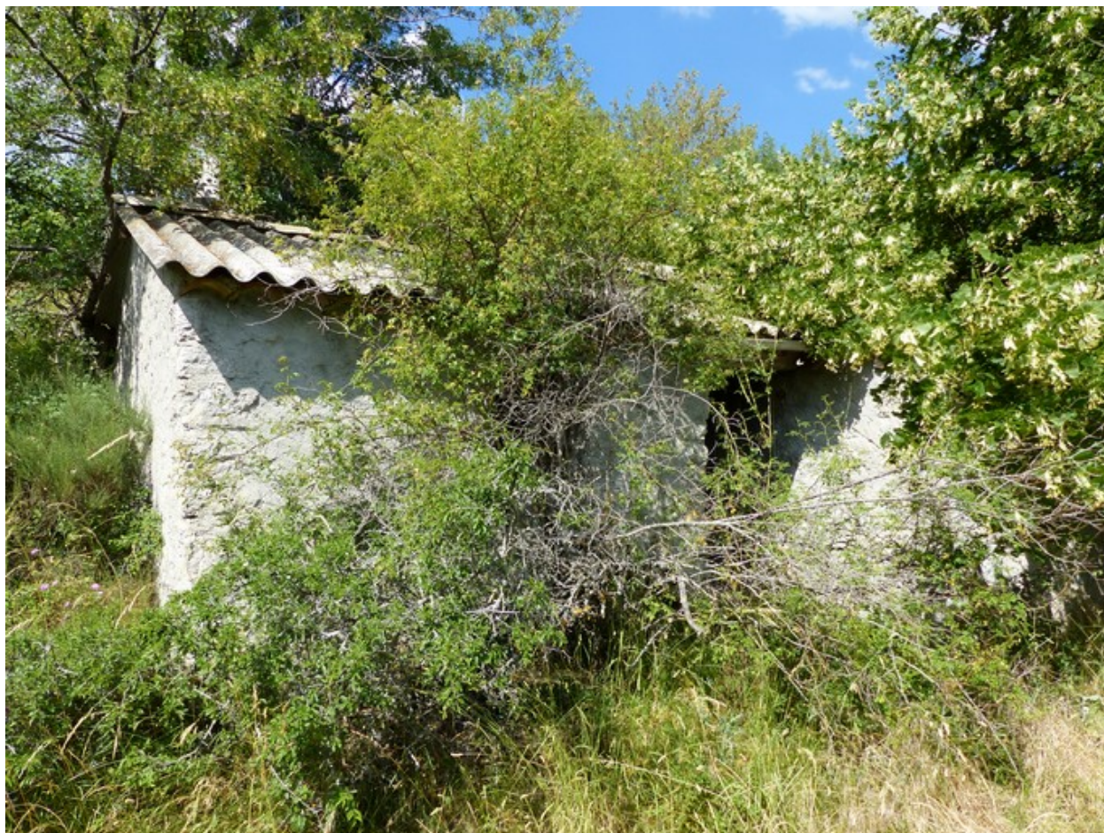
Partie occidentale, vue d'ensemble prise du sud-ouest.
