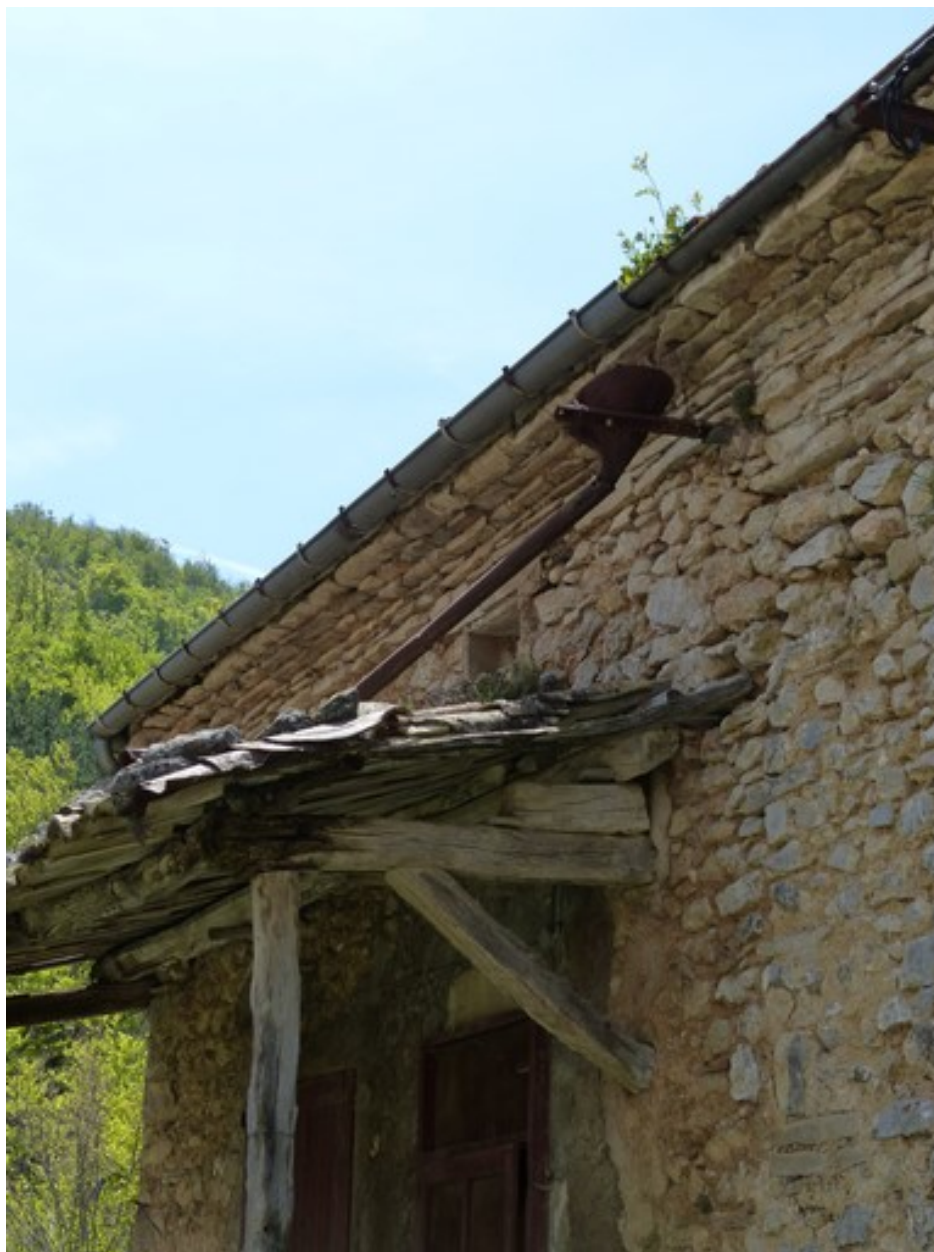
Ensemble occidental. Élévation sud, collecteur de citerne.
