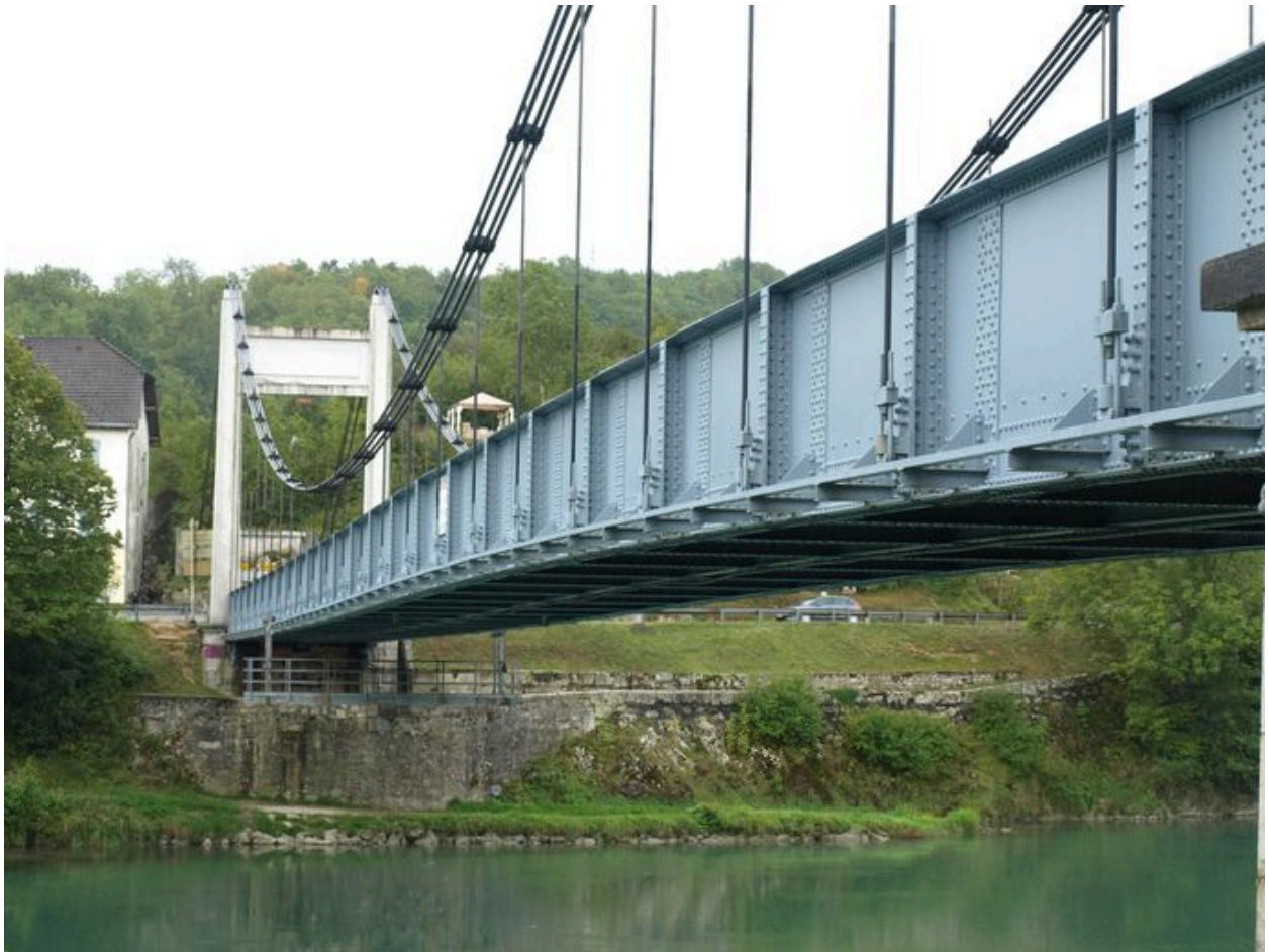
Vue partielle, de côté, travée centrale et culée gauche, face amont (depuis la rive droite)
