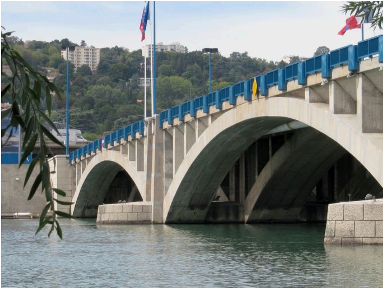
Vue partielle, travées centrale et droite, face aval (depuis la rive gauche)
