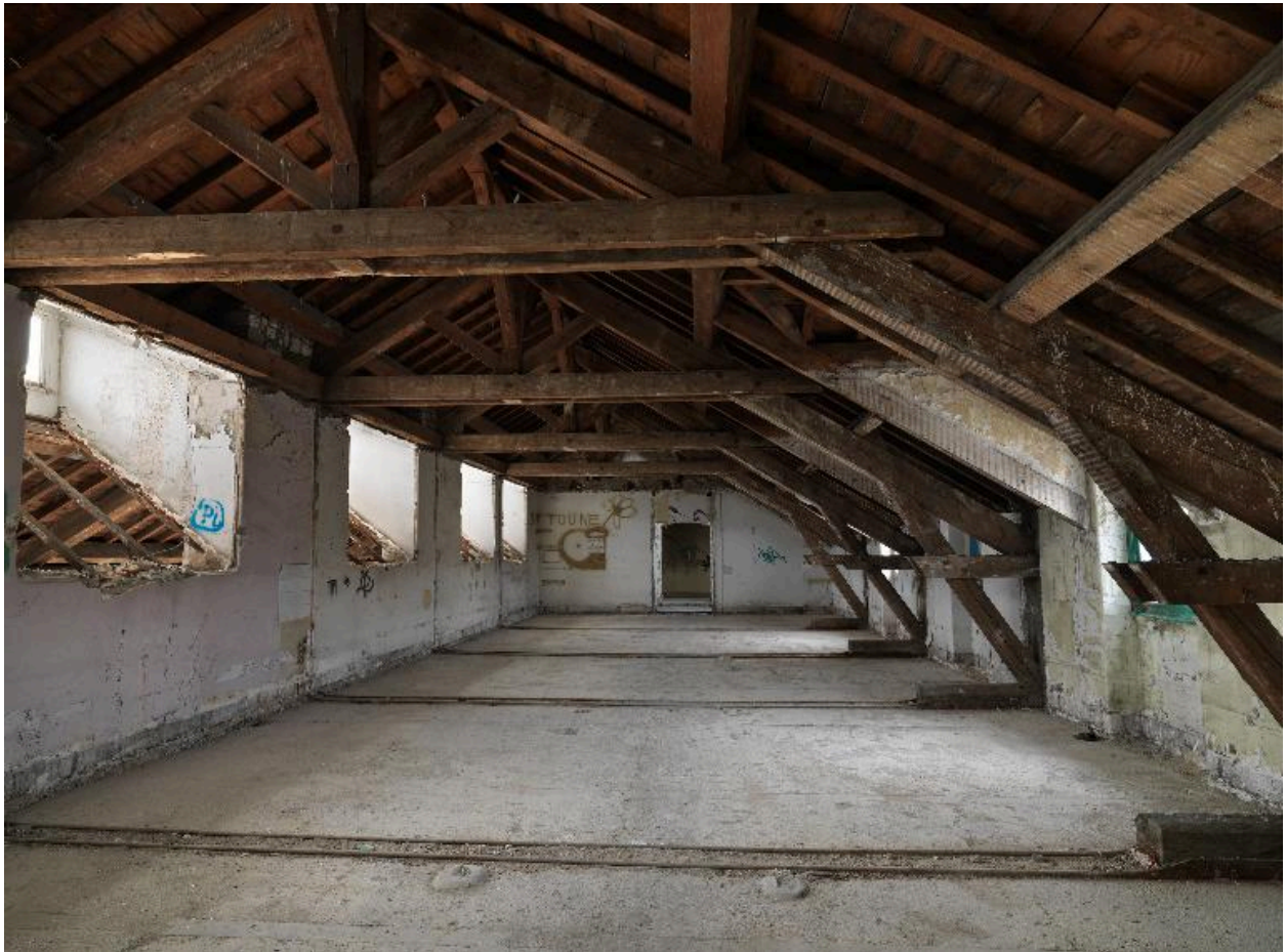
Etat en janvier 2015 : bâtiment B, partie latérale nord, la charpente
